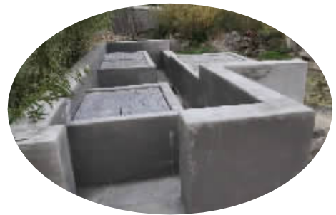
改造后的污水井
