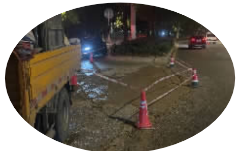
夜间修复路面现场
