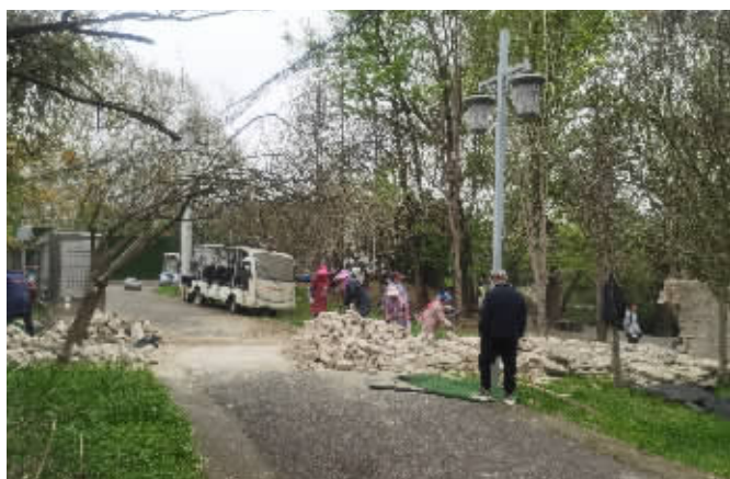
工人正在拆除围墙
