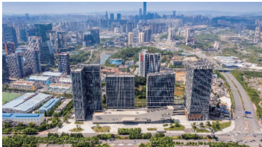
图为:阳光城·启航中心项目
