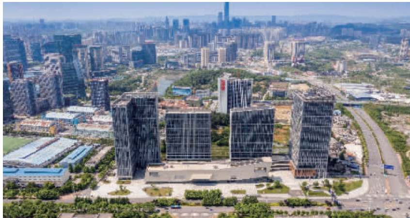
图为：阳光城·启航中心项目
