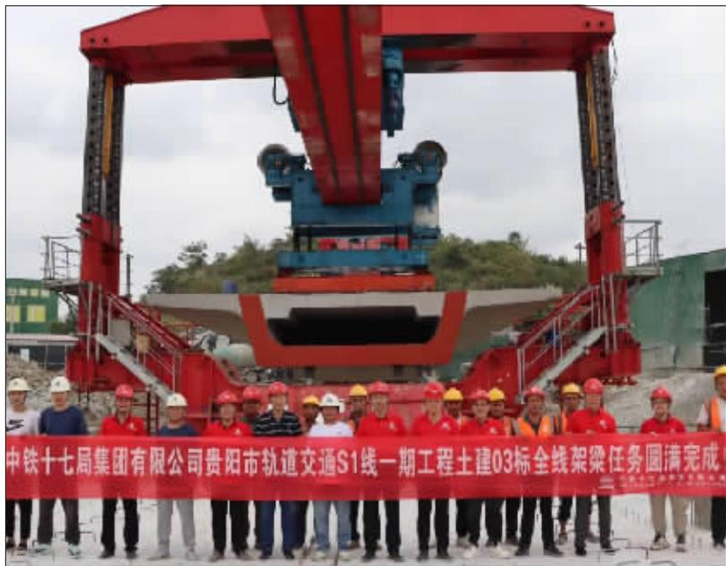
本报讯 9月20日，随着架桥机将重达500余吨的箱梁缓缓吊离运输车辆，经过提梁、纵移、落梁等工序后，贵阳轨道交通S1线全线最后一孔箱梁被稳稳安放在桥墩墩顶之上，标志着贵阳轨道交通S1线全线架梁任务顺利完成。
