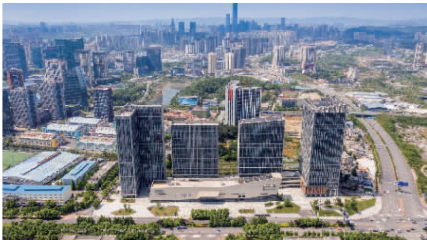
图为:阳光城·启航中心项目
