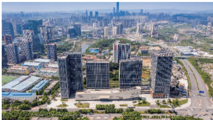
图为：阳光城·启航中心项目
