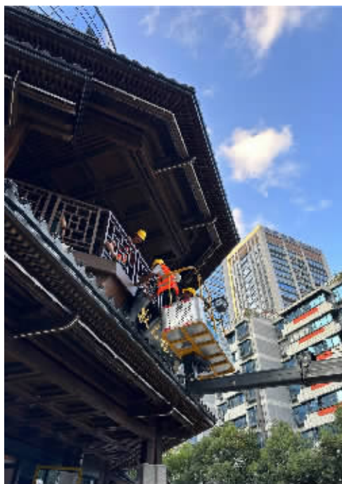
施工中的曹状元街区（状元楼）
