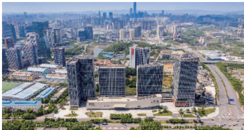
图为:阳光城·启航中心项目
