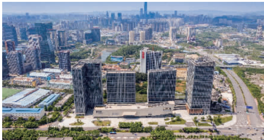
图为:阳光城·启航中心项目
