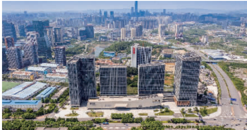
图为：阳光城·启航中心项目
