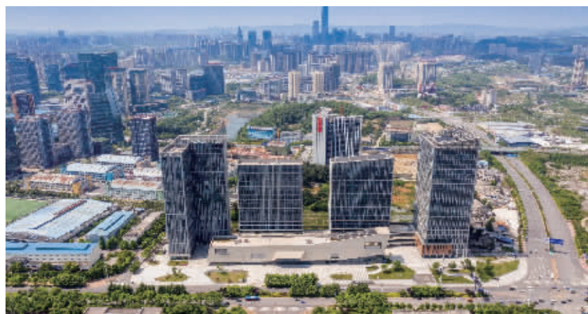
图为:阳光城·启航中心项目
