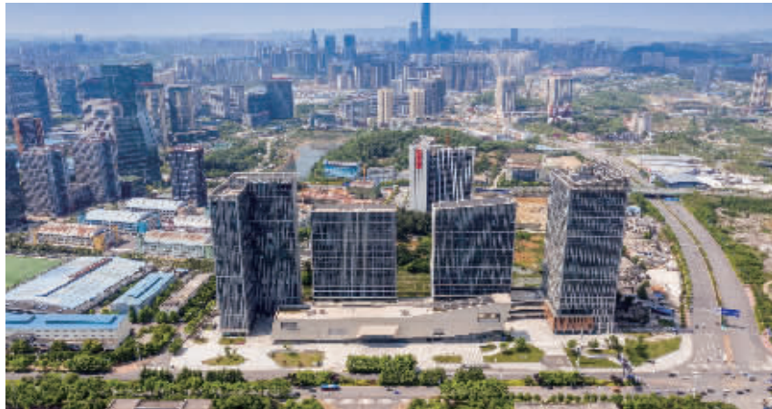
图为:阳光城·启航中心项目
