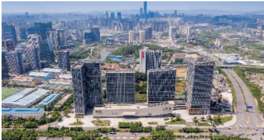
图为：阳光城·启航中心项目
