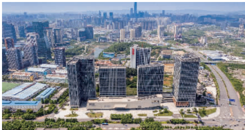
图为：阳光城·启航中心项目
