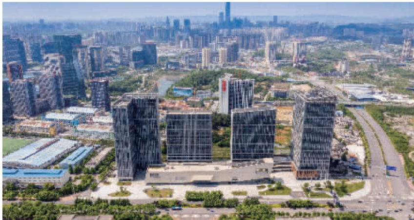
图为：阳光城·启航中心项目
