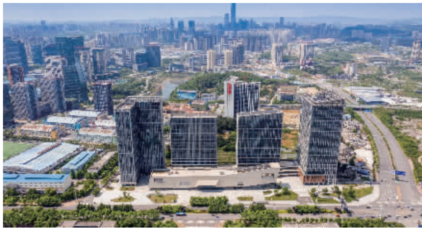
图为:阳光城·启航中心项目
