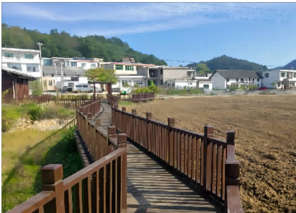
修文县扎佐街道改造民房,提升乡村“颜值”。 贵阳日报融媒体记者 潘朝选 摄
