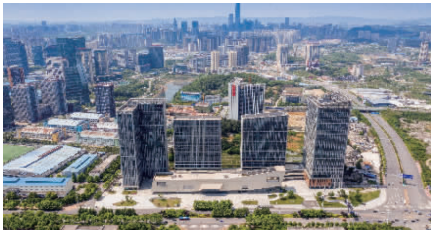
图为:阳光城·启航中心项目
