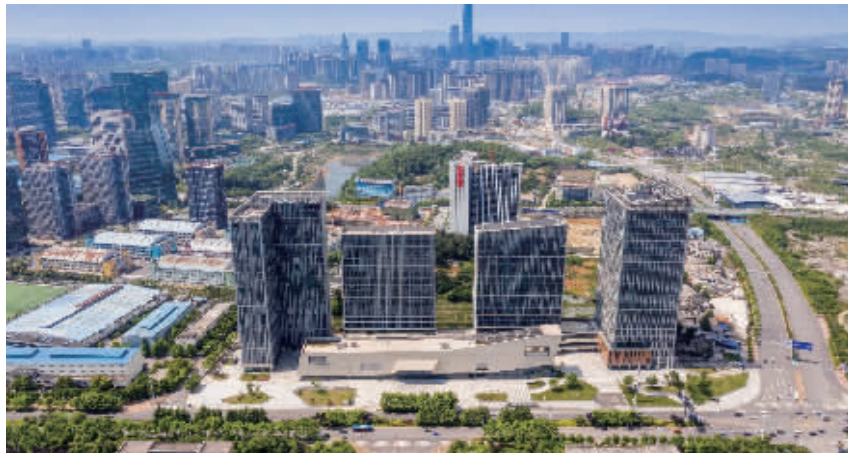
图为:阳光城·启航中心项目
