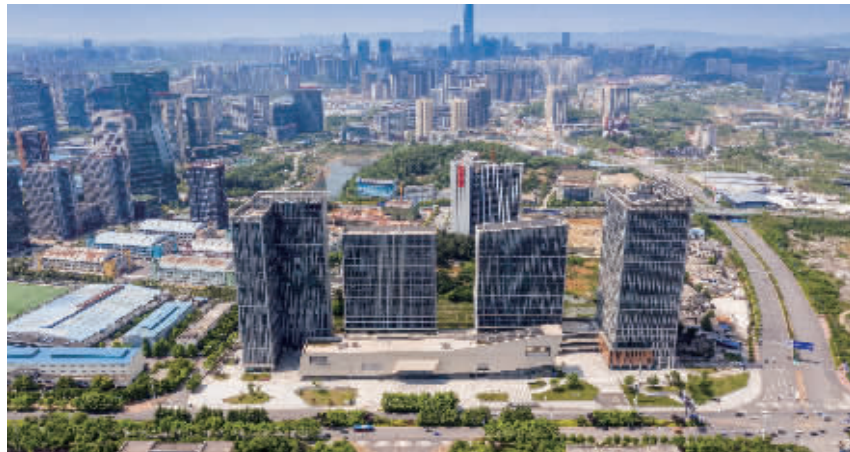
图为：阳光城·启航中心项目
