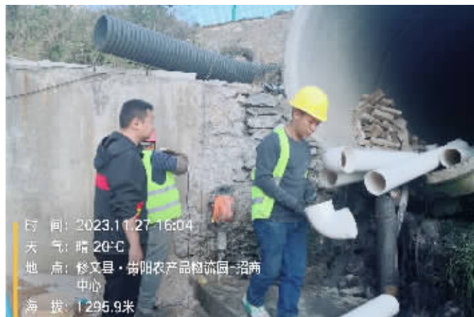
工人正在安装污水管道
