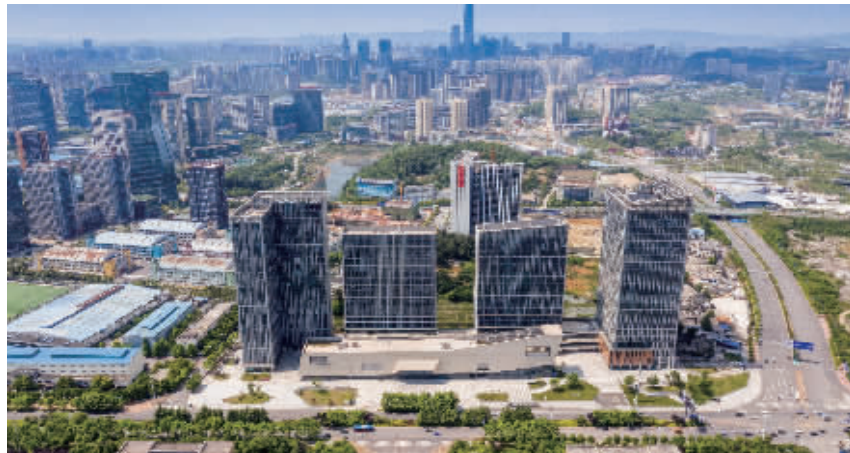
图为:阳光城·启航中心项目
