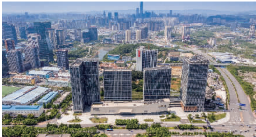
图为：阳光城·启航中心项目
