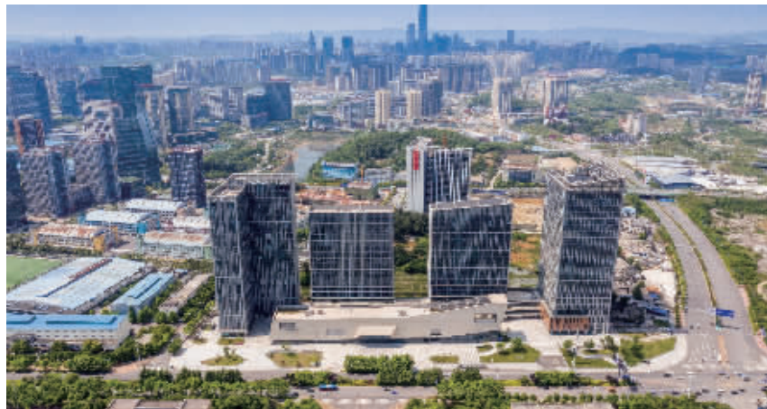
图为：阳光城·启航中心项目
