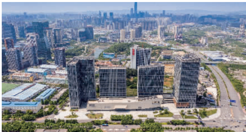
图为:阳光城·启航中心项目
