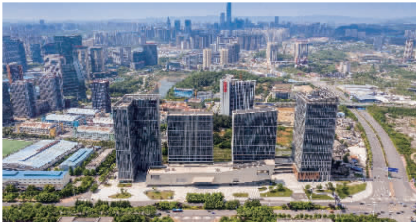
图为：阳光城·启航中心项目
