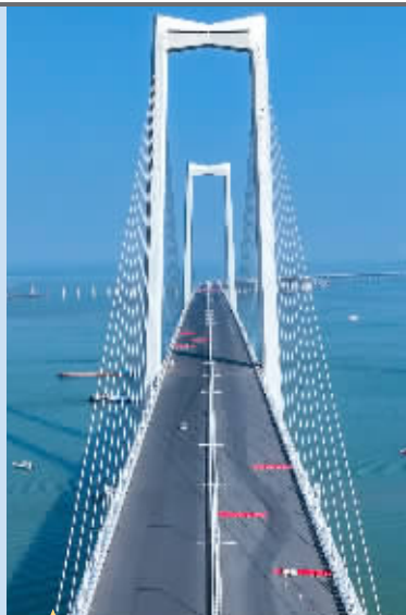
深中通道中山大桥为主跨580米的双塔斜拉桥,主塔高213.5米,由120根斜拉索连接主塔与桥面,如“竖琴”跃于海面。
