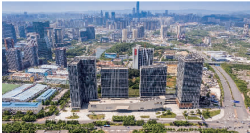
图为：阳光城·启航中心项目
