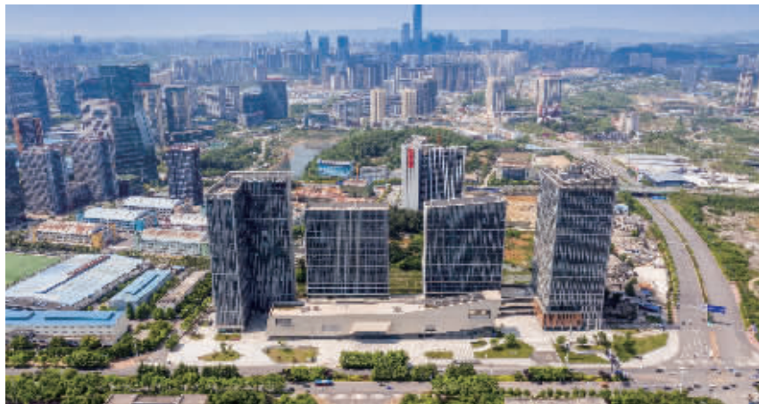
图为:阳光城·启航中心项目
