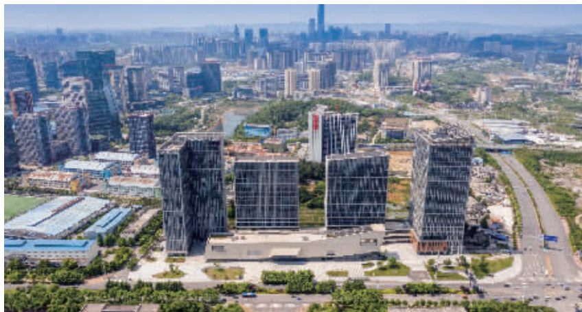
图为：阳光城·启航中心项目
