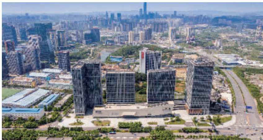
图为:阳光城·启航中心项目
