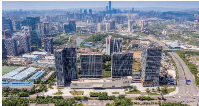
图为:阳光城·启航中心项目
