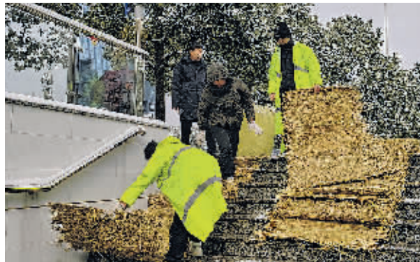
1月22日,高新区应急管理局工作人员在地下通道铺设防滑草垫 贵阳日报融媒体中心记者 陈佳艺 摄
