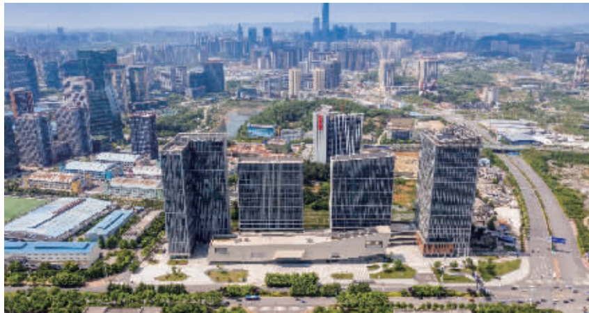
图为：阳光城·启航中心项目
