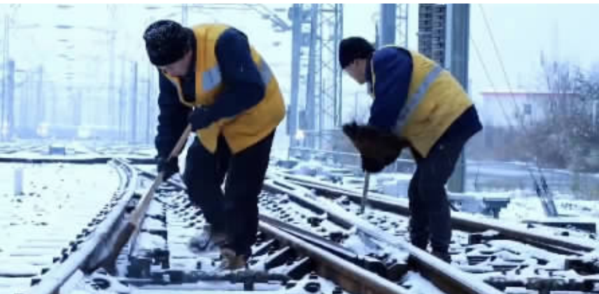
贵阳高铁工务段工人开展道岔除雪作业。
