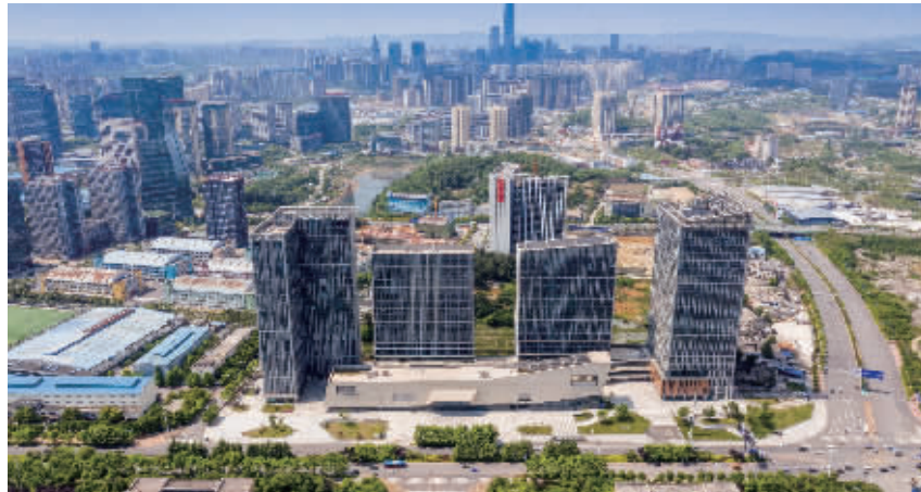
图为:阳光城·启航中心项目
