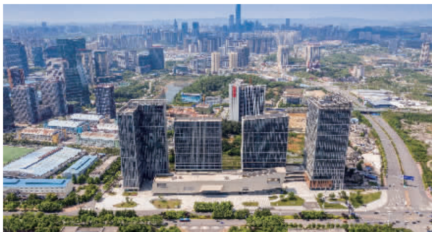
图为:阳光城·启航中心项目
