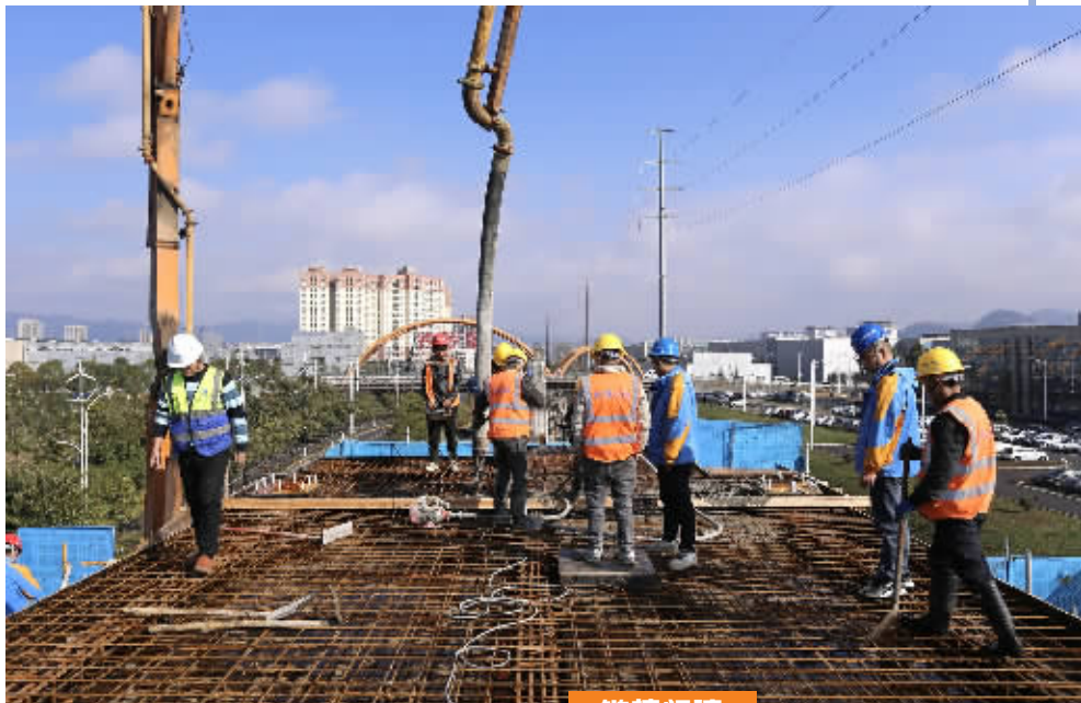
黎阳大道站,工人正在进行混凝土浇筑作业
