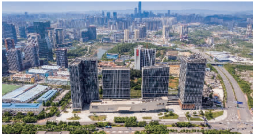
图为:阳光城·启航中心项目
