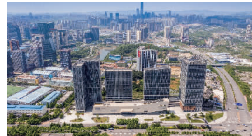
图为:阳光城·启航中心项目
