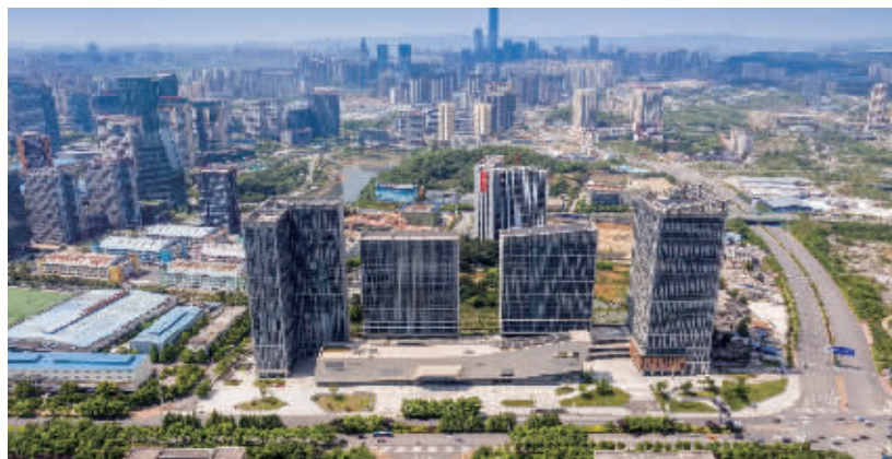
图为：阳光城·启航中心项目
