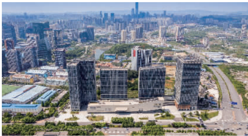
图为：阳光城·启航中心项目
