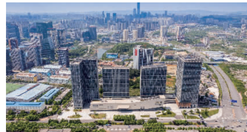
图为：阳光城·启航中心项目
