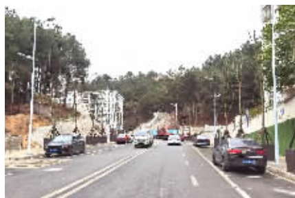
道路上安装了交安设施
