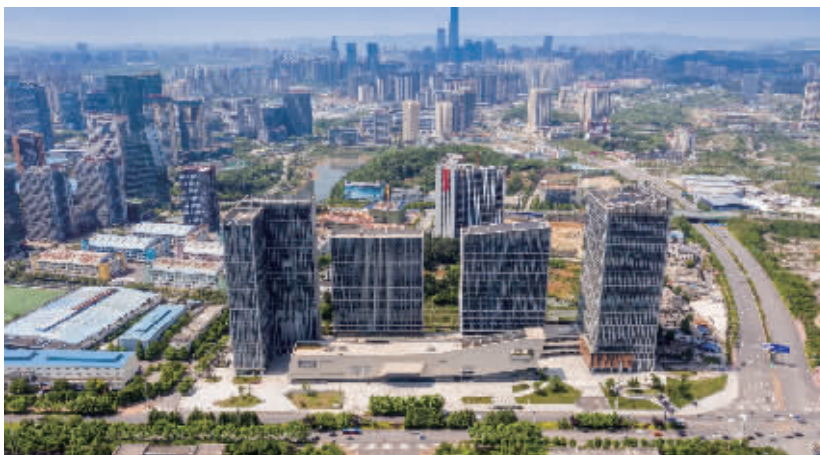
图为阳光城·启航中心项目
