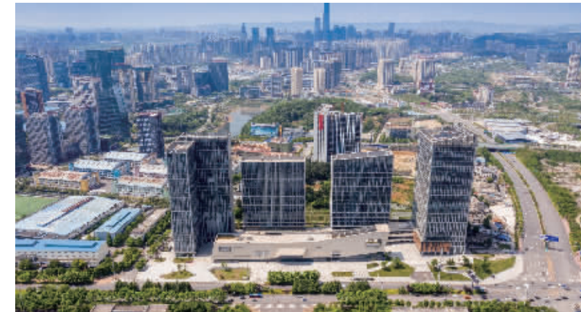
图为阳光城·启航中心项目
