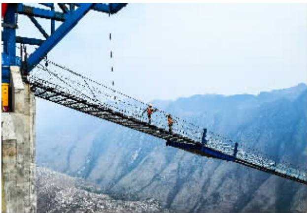
3月27日，工人在花江峡谷大桥的施工猫道上加固防护网（手机照片）
