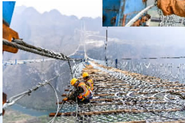
3月27日，工人在花江峡谷大桥的施工猫道上施工
