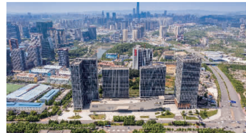
图为阳光城·启航中心项目
