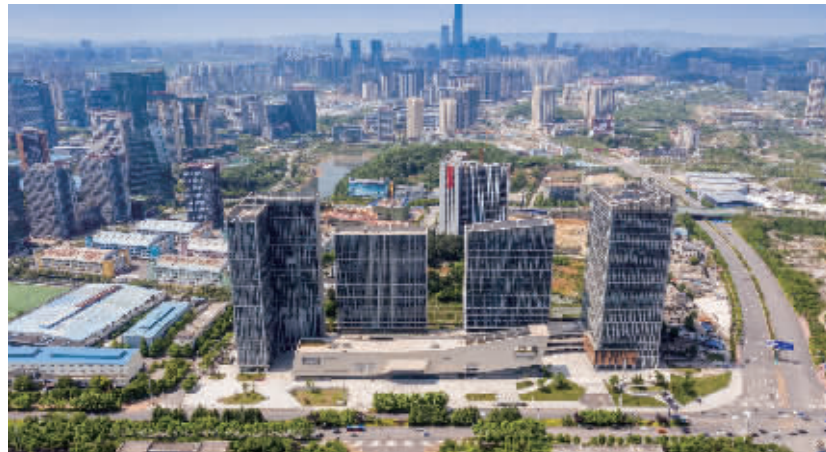
图为阳光城·启航中心项目
