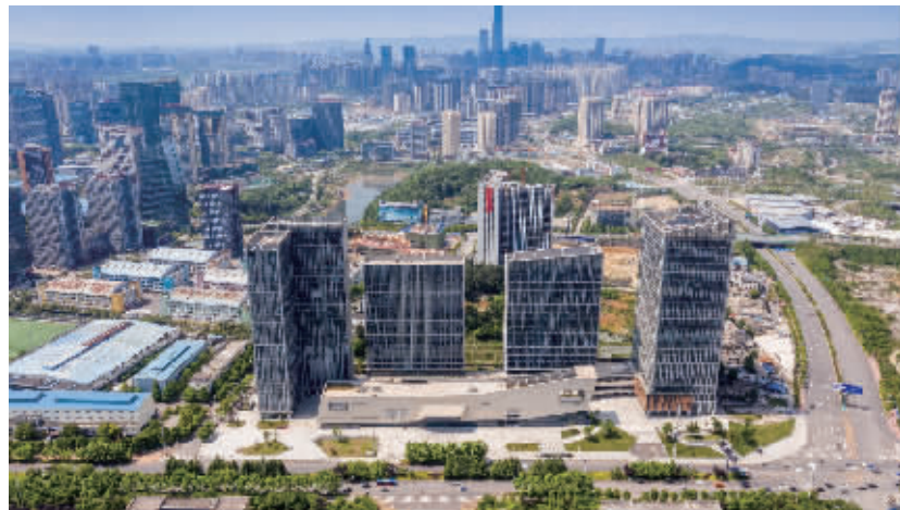
图为阳光城·启航中心项目
