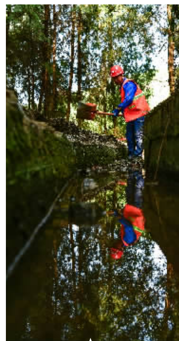
工人对天渠进行维护
