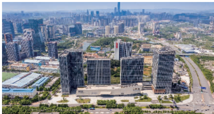
图为阳光城·启航中心项目
